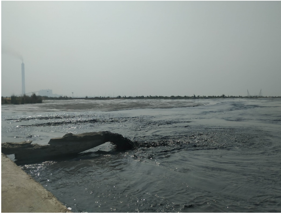
Figure 27: TTPS Ash Pond - Ash slurry flowing into pond, TTPS chimney visible in background
